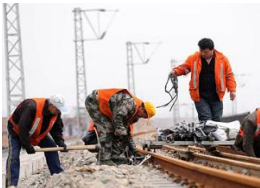
黄韩侯铁路侯西段电气化复线施工
